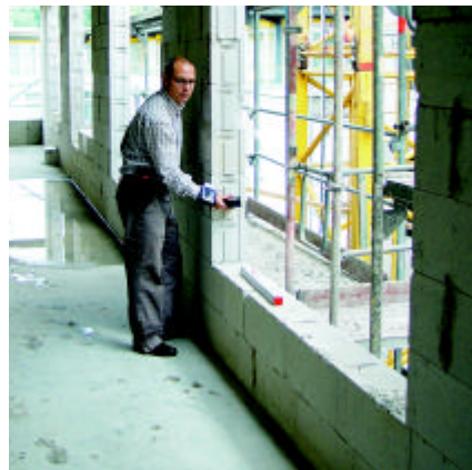
Das Punktlasermessgerät erfasst die Maße mit einer Genauigkeit von ±1 mm
